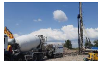
Port de Bordeaux : 1,3 MW
