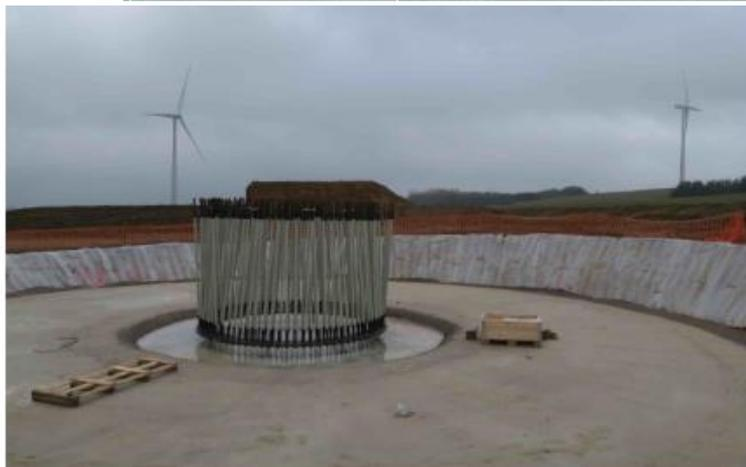
Sont bien visibles ici le radier et la cage d'ancrage de d'éolienne, sur laquelle sera vissée la première section de la tour. Tous les efforts exercés par le vent sur l'éolienne seront transmis à cette cage et amortis à travers les fondations.
