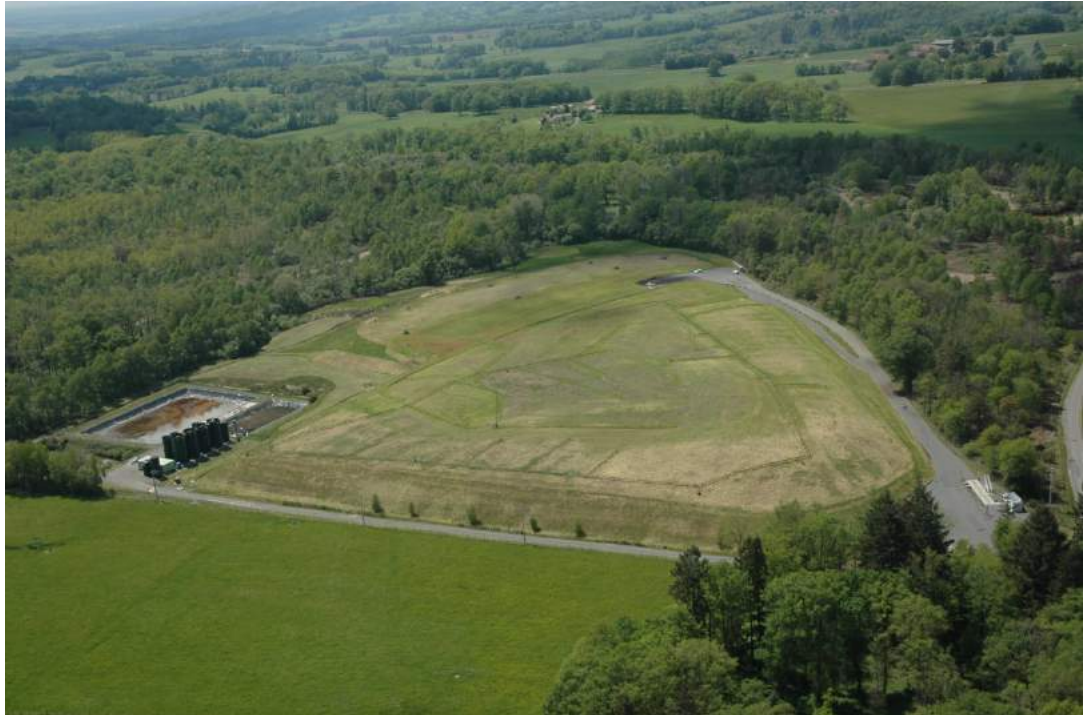
Vue aérienne du site de Rouzède
